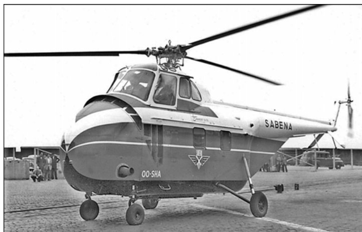
Le premier Sikorsky S-55 de la Sabena. Doté d'un moteur à pistons de 600 CV logé dans le nez, cet hélicoptère peut transporter sept passagers. (Archives Jean-Pierre Decock).
