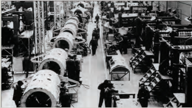
Chaîne de montage des fuselages à Gosselies.
