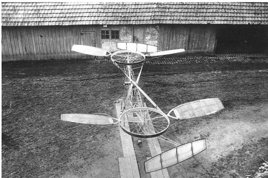
Dit verticaal zicht van Cornu's helikopter toont de schikking van de riemtransmissie.
