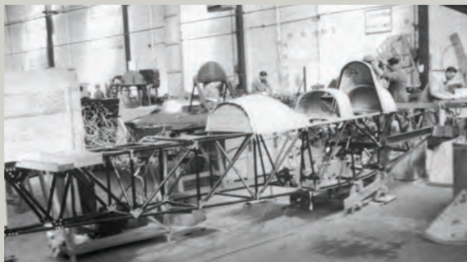
La construction métallique du fuselage du SR-7B De metalen constructie van de romp voor de SR-7B.
