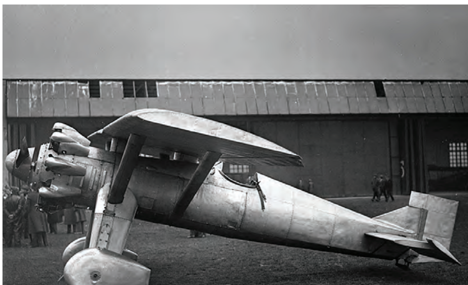
Le Renard Épervier au moteur Gnome-Rhône de 480 CV devant les installations de la SABCA.
