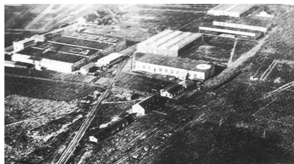
Vue aérienne Luchtfoto - 1922.
