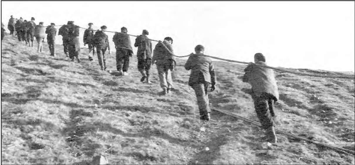
Pour remettre en état le fil de Mendive, le nouveau câble est porté à l'épaule.
