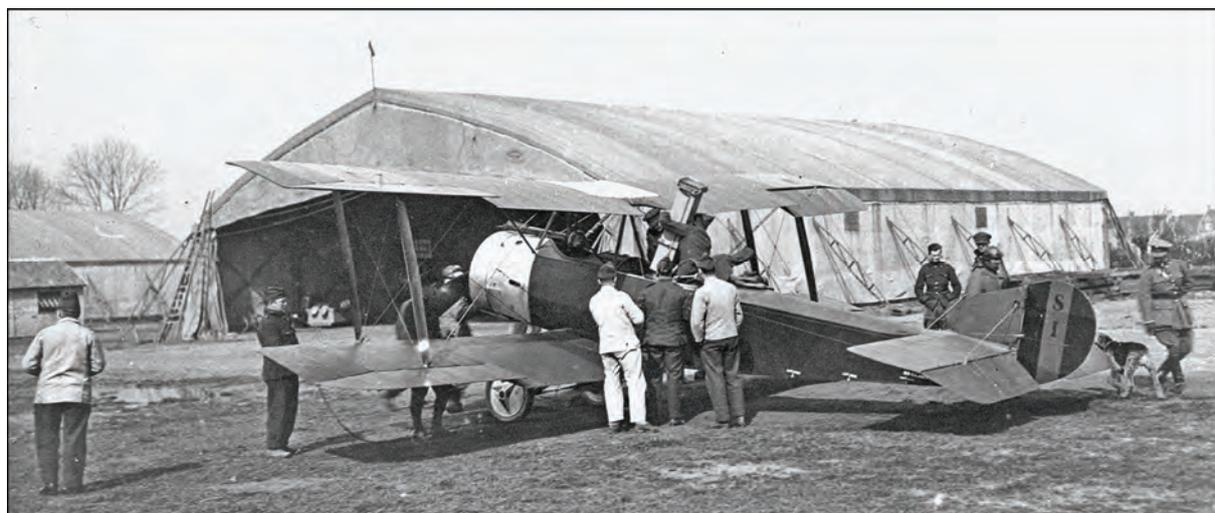
Installation d'un appareil photographique à longue focale dans le poste de l'observateur-opérateur de l'avion Sopwith « 1 ½ Strutter » n° S 1 de la 4<sup>e</sup> Escadrille. (Collection Georges Lecomte, via Mme Laure Gisseleire, sœur d'Albert Gisseleire, pilote de la 4<sup>e</sup> Escadrille, tombé en combat aérien le 3 octobre 1918)
