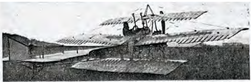
Monoplan fixe : 12 m 2 . Deux plans équilibrés à incidence (0 à 70°) commandée 2 x 6 m 2 . Brevet n° 238402 (16 août 1911) César Battaille.
